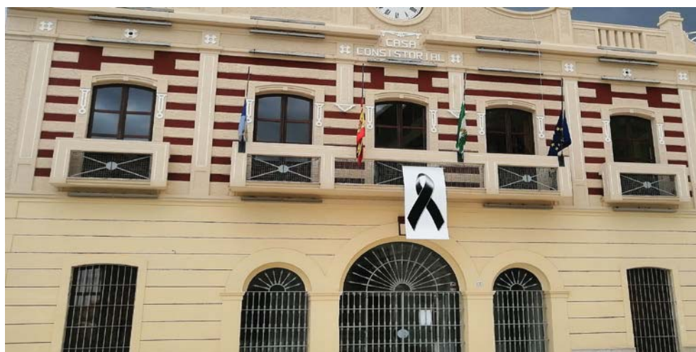
Figura 3. Fachada de la casa consistorial del Ayuntamiento de Garrucha el 14 de mayo 2020. Fuente: original del propio autor.
