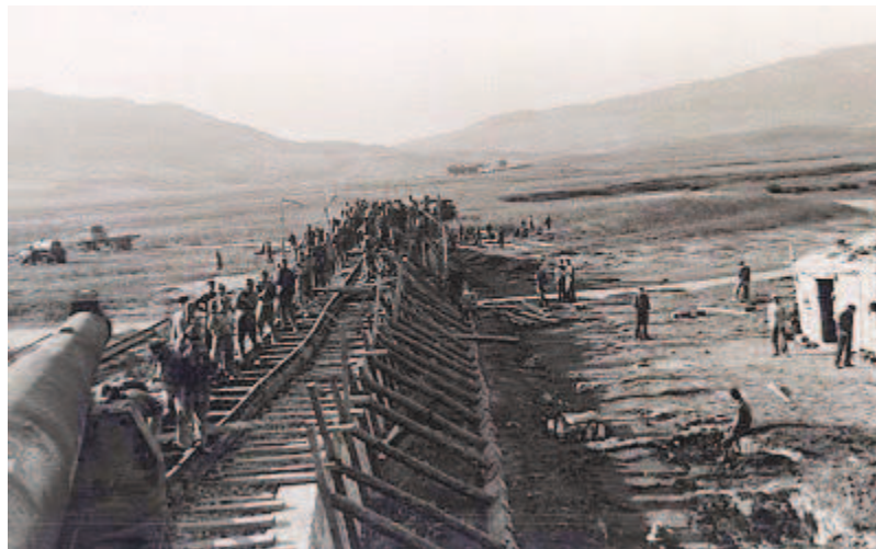
Imagen 2. Paso de un cañón sobre el puente del río Jara, Tarifa,
