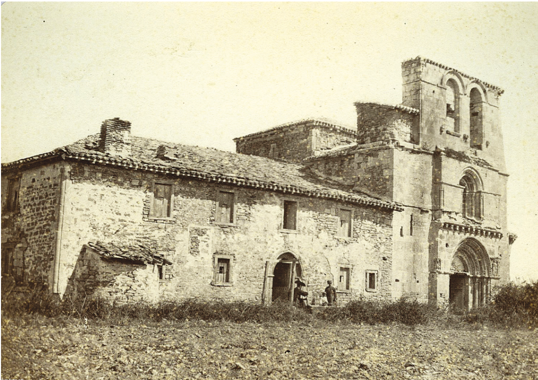
Figura 2. Anónimo, Vista de la fachada sur a finales del siglo XIX (foto: Archivo Municipal de Vitoria-Gasteiz Pilar Aróstegui, B-008).
