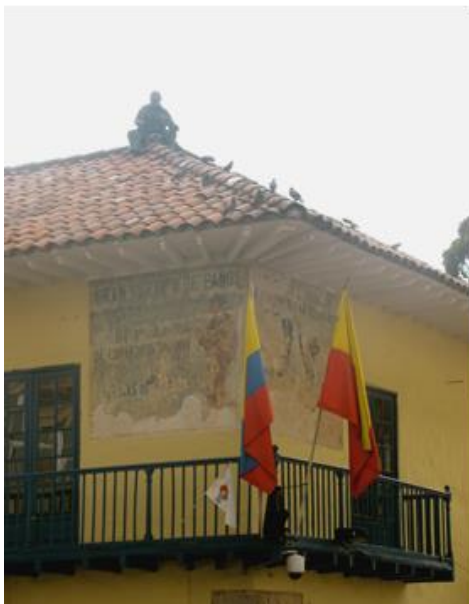
Imagen 7. Construcción ubicada al costado Izquierdo del capitolio Nacional, en su fachada aún se aprecia un aviso publicitario de una antigua tienda de paños
