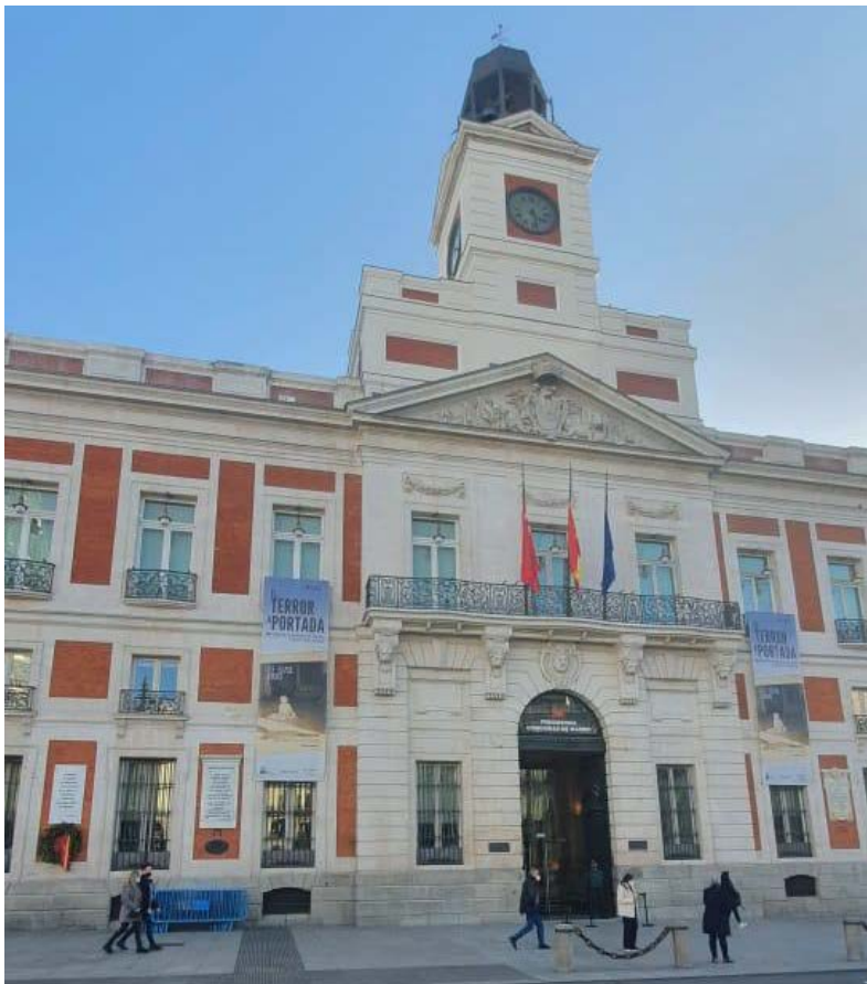
Figura 17: Edificio sede de la Presidencia de la Comunidad de Madrid
